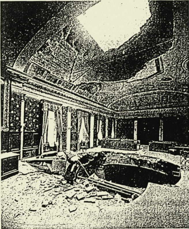
Vue de la salle des Abeilles dont le plafond et le sol sont effondrés.
