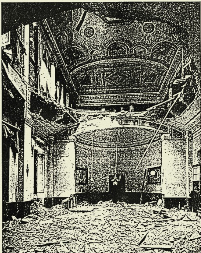
Vue de la salle du tribunal de première instance.
